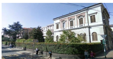
Figura I.4. 2 A sinistra l’“Edificio Vecchio” e a destra l’“Edificio Nuovo”.
