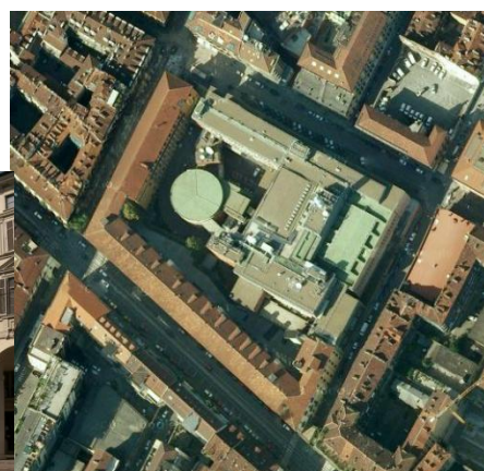
Figura I.3. 1 Palazzo degli Stemmai di via Po n. 29/37, Torino (TO).
