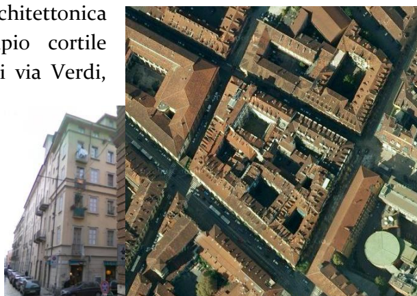
Figura I.6. 1 Palazzo Badini di Via Verdi n. 10, Torino (TO).
